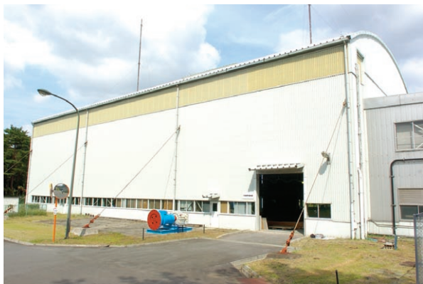
（独）防災科学技術研究所・大型振動実験棟
